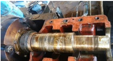
آسیب دیدن شافت پمپ به‌دلیل تخریب کامل تکیه‌گاه در اثر عدم ایجاد فیلم روغن و تماس مستقیم با محور پمپ
