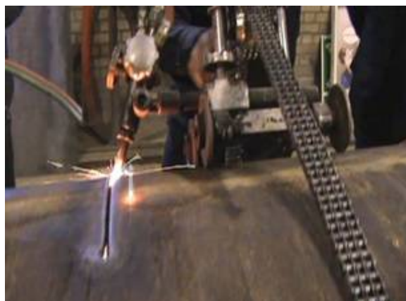
شکل 1 برش کاری لوله
